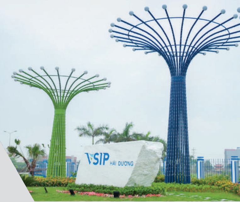
NHÀ MÁY AIRTECH THẾ LONG TỌA LẠC TẠI KCN VSIP HẢI DƯƠNG
